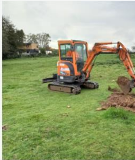
Sondage à la pelle méca
