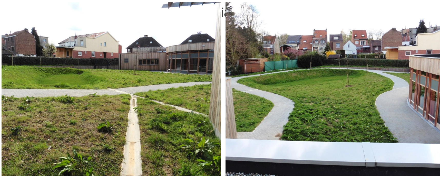
Bâtiment exemplaire, Rue Potaarde 268, 1082 Berchem-Sainte-Agathe – Photos : MATRIciel
