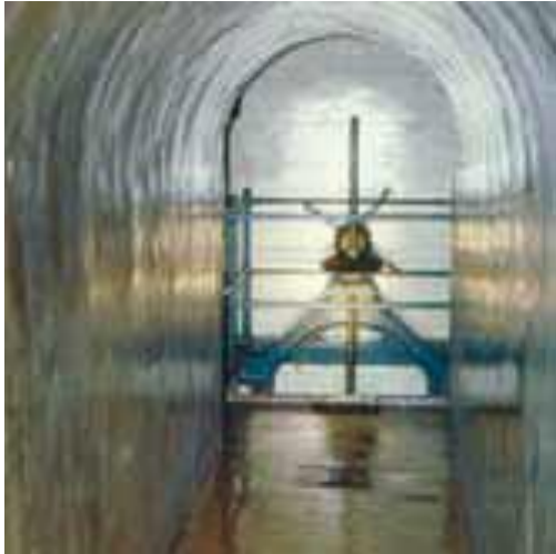
Serrement de la galerie de la forêt de Soignes – Source: Vivaqua
