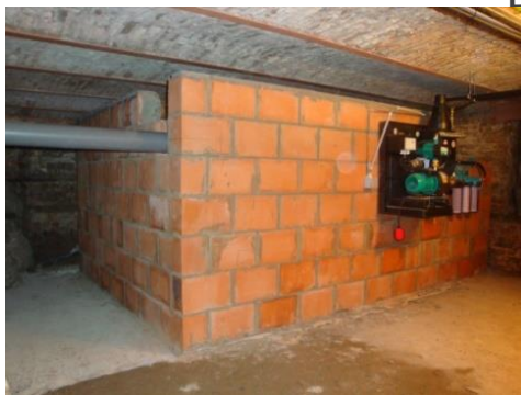
Citerne existante rénovée BATEX [046] – Droguerie
