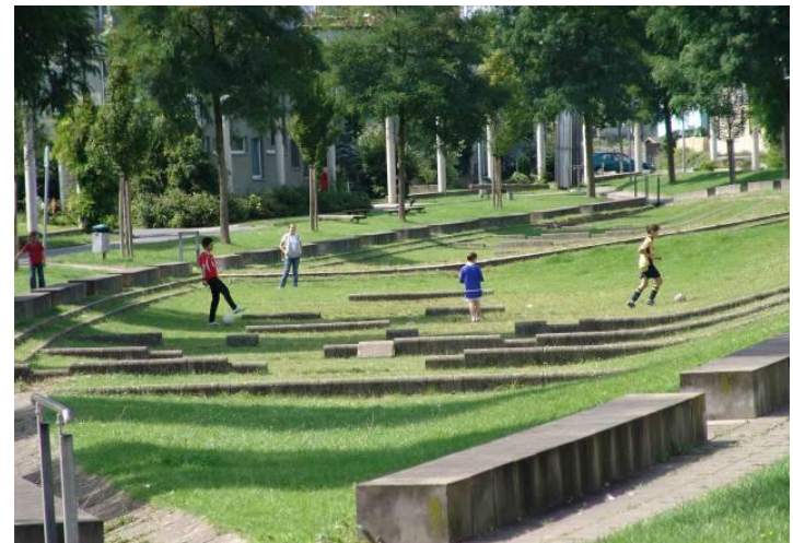
Bassin sec, quartier Küppersbusch, Gelsenkirchen Photo : Valérie MAHAUT / Réalisation : Herbert DREISEITL
