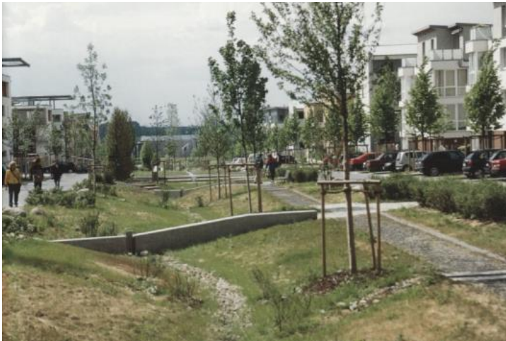
Aménagement de bassins de rétention d'eau, Hanovre Photo : Valérie MAHAUT / Réalisation : Herbert DREISEITL
